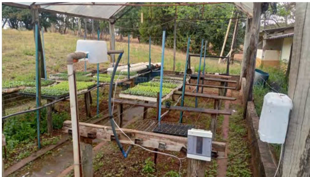
Figura 3- Vista geral da horta escolar com o sistema de irrigação automatizada instalado.
